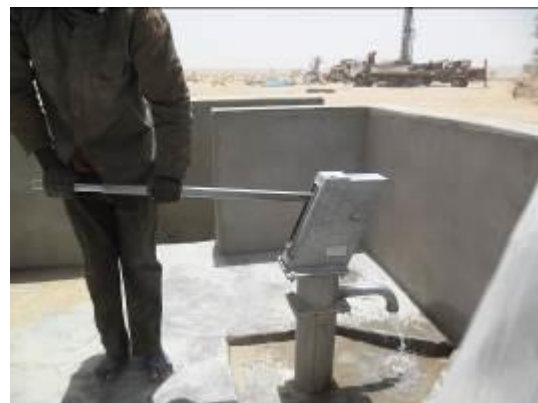
Forage équipé d'une pompe à motricité humaine dans la commune de Tinzawaten
