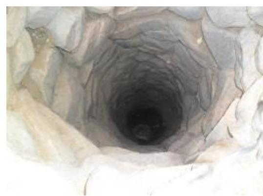
Cuvelage d'un puits traditionnel dans la commune d'Abeibara
