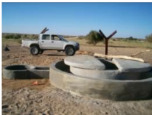
Puits moderne dans la commune de Tinzawaten
